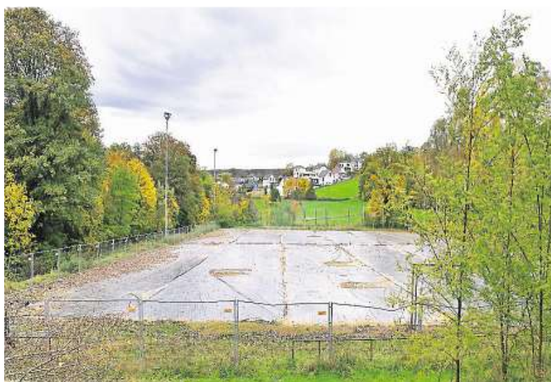
Beim künftigen Kita-Gelände auf dem alten Sportplatz „Hasenberg“ muss die kontaminierte Oberschicht abgetragen werden.
