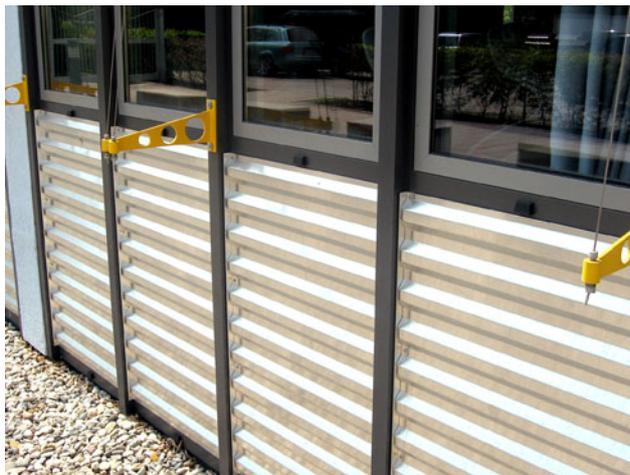
Außenverkleidung einer Wand mit Aluminiumblech
