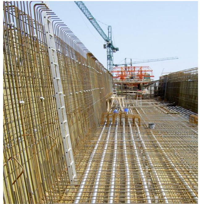
Armierung aus Stahl vor dem Betonguss
